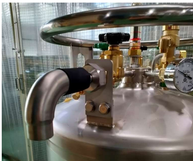
直付け型サイレンサー取付け写真
